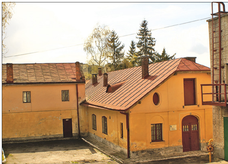
Budynek ambulatorium Katedry Chorób Wewnętrznych
