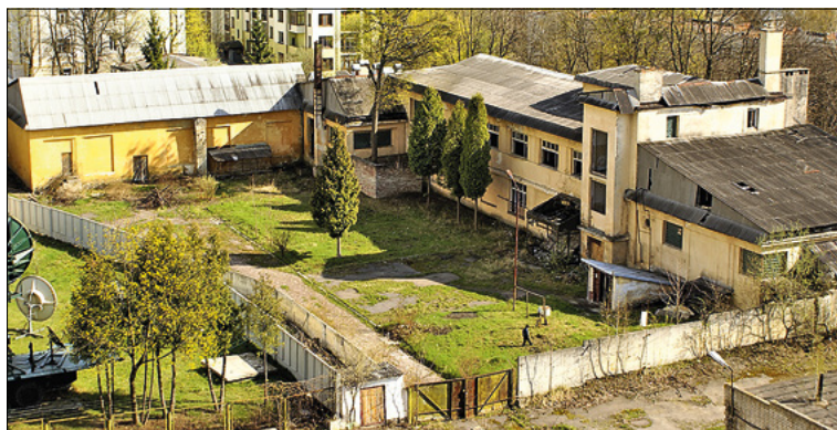
Budynki Zakładu Położnictwa i Ortopedii, obecnie w ruinie
