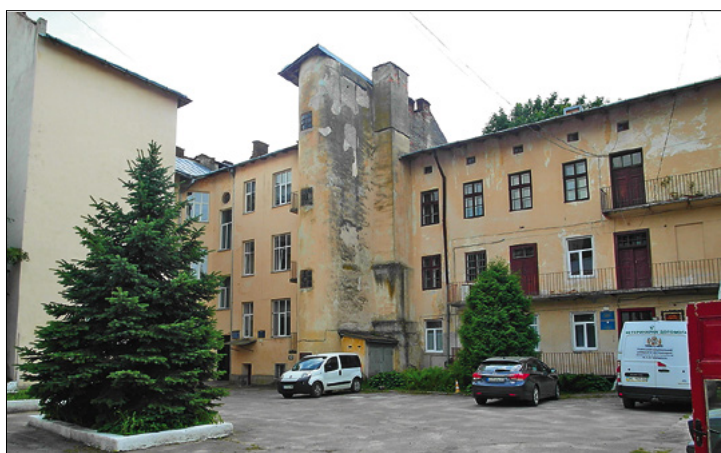
Budynki zakładów naukowych
