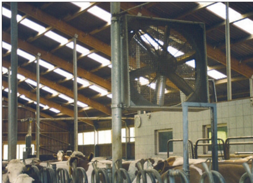
Ryc. 1. Wiatrak elektryczny zainstalowany w oborze
