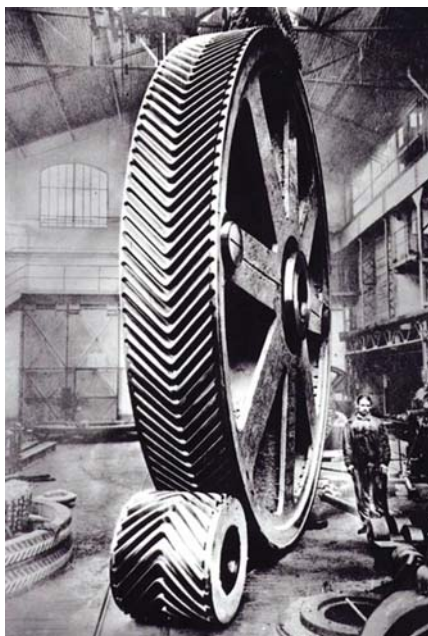
Ryc. 11. Olbrzymie koła zębate z zazębieniem daszkowym produkcji Citroën.
