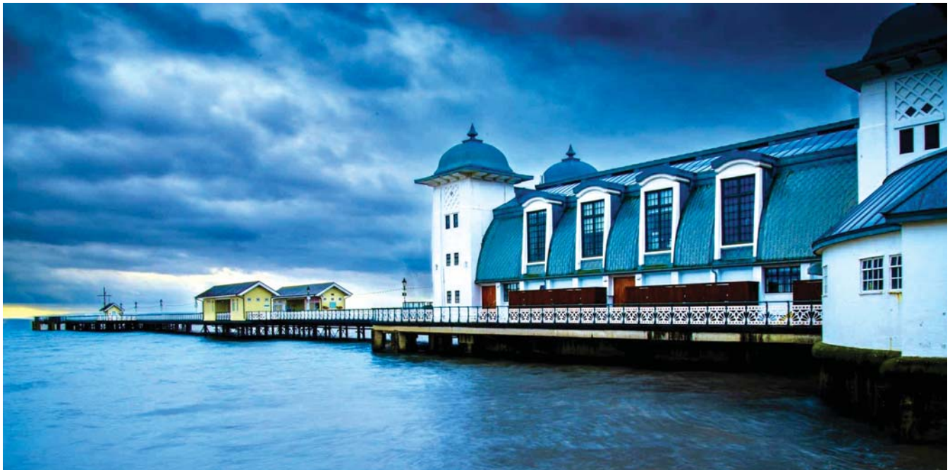
Penarth Pier (molo w Penarth) i znajdujący się na nim pawilon, położone w pobliżu Cardiff, na wybrzeżu południowej Walii.
